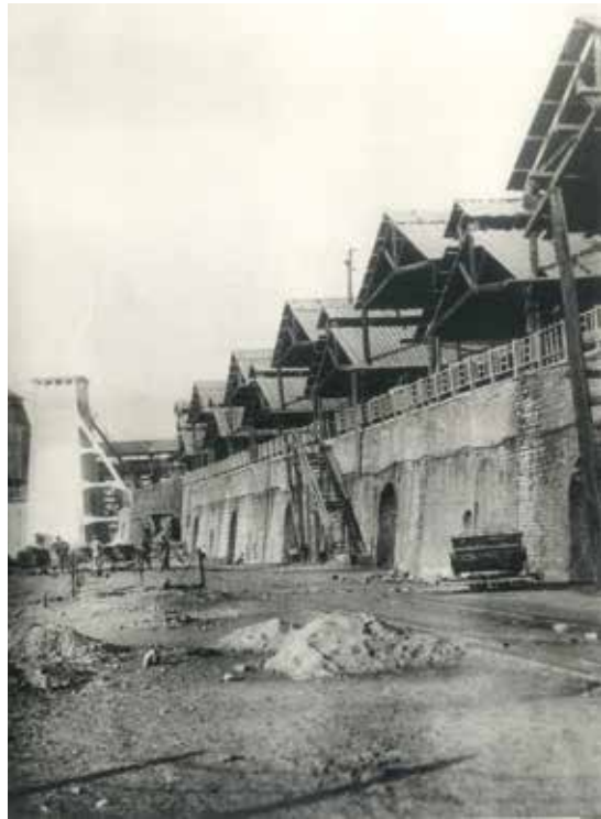
Fig. 2 - Immagine d'epoca. Forni Gill e Pozzo Donegani
