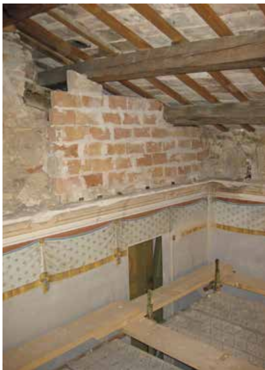
Fig. 26 - Copertura. Immagine galleria sottotetto dopo rimozione controsoffitto in cartongesso
