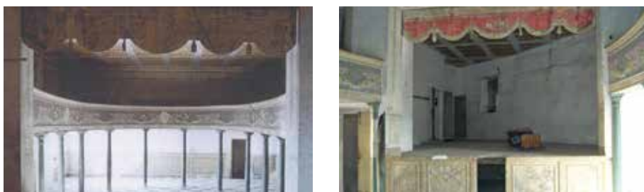
Fig. 3 - 4 - Immagini prima dei lavori
