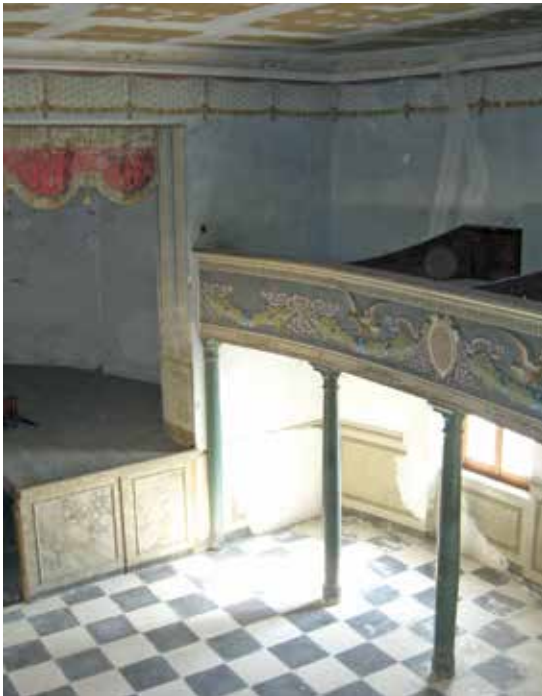
Fig. 5 - Immagine prima dei lavori
