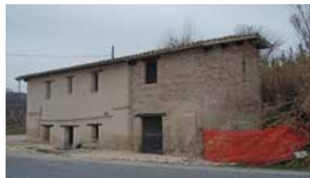
Fig. 2 - Casa di terra dopo il restauro
