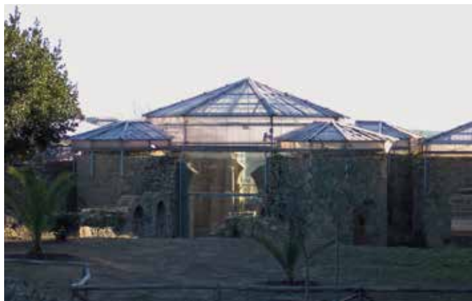
Fig. 1 - Le coperture "evocative" progettate da Franco Minissi per la Villa del Casale a Piazza Armerina prima della loro rimozione. (Foto S. Gizzi, 2006)
