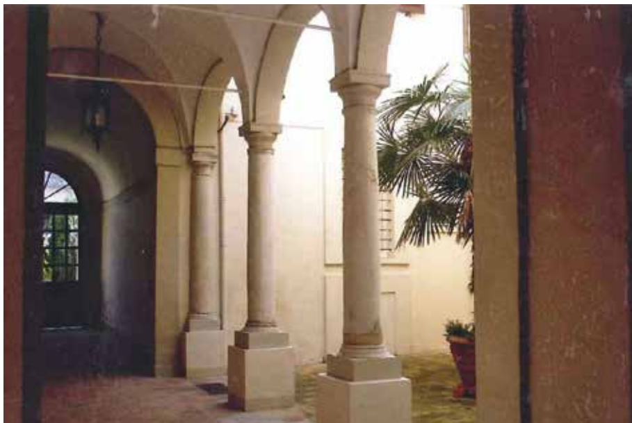
Fig. 7 - Fano (PU) - Immobile in via Nolfi n° 49. Particolare del cortile interno
