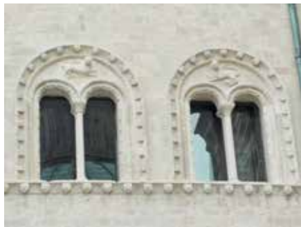
Fig. 2 - Bifore dopo il restauro
