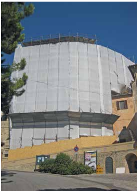
Fig. 23 - Prospetto lato sud. Opere provvisionali
