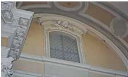
Fig. 1 - Zona del transetto prima del restauro
