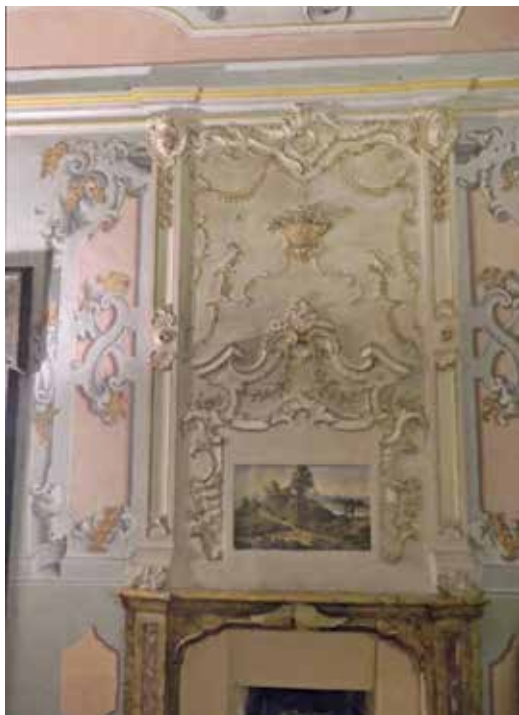
Fig. 13 - Ambiente di gusto tardo barocco. Particolare della decorazione a parete
