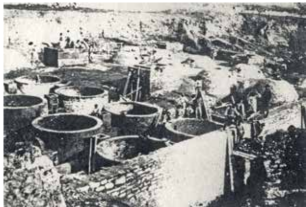
Fig. 4 - Immagine d'epoca. Costruzione dei forni Gill
