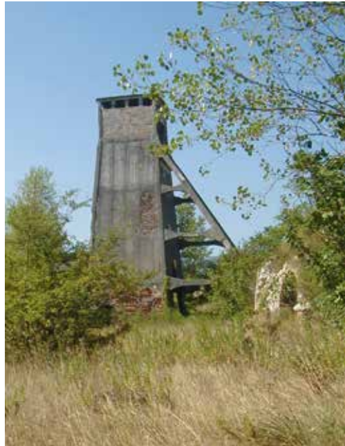
Fig. 5 - Il Pozzo Donegani prima dei restauri
