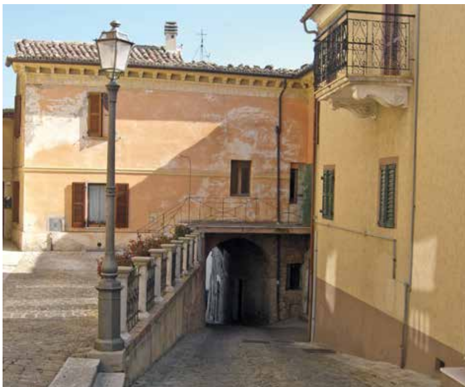
Fig. 14 - Interno del Castellare. Ballatoio con accesso diretto alla platea
