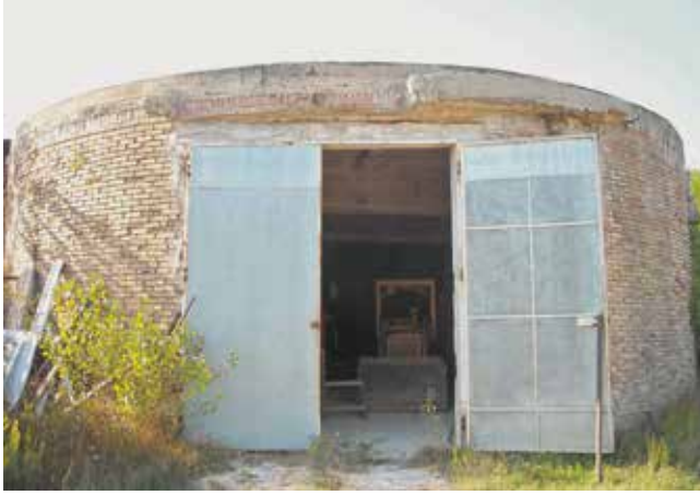
Fig. 6 - Il serbatoio della nafta prima del restauro
