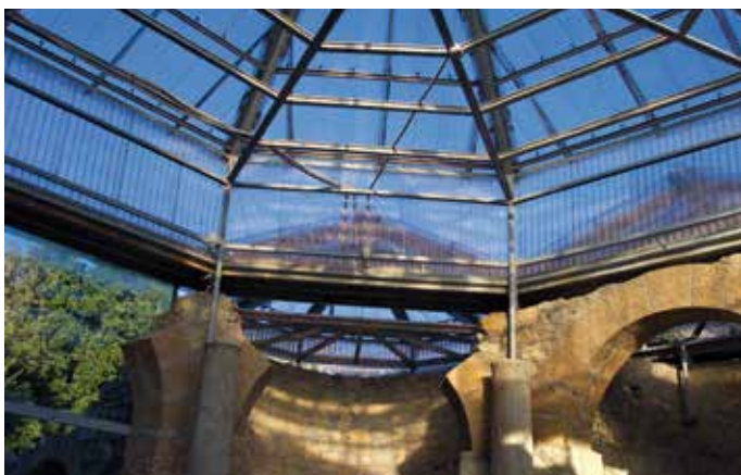
Fig. 2 - Particolare dell'aggancio della copertura trasparente in plexiglass e acciaio sulle murature romane secondo il progetto di Franco Minissi per la Villa del Casale a Piazza Armerina. (Foto S. Gizzi, 2006)
