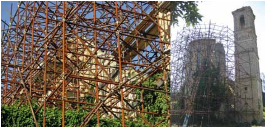
Fig. 5 - Ponteggi vista esterna
