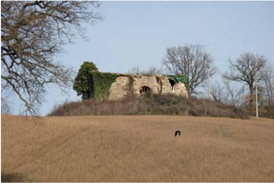
Fig. 5 - Il lato Sud prima dell'intervento di restauro
