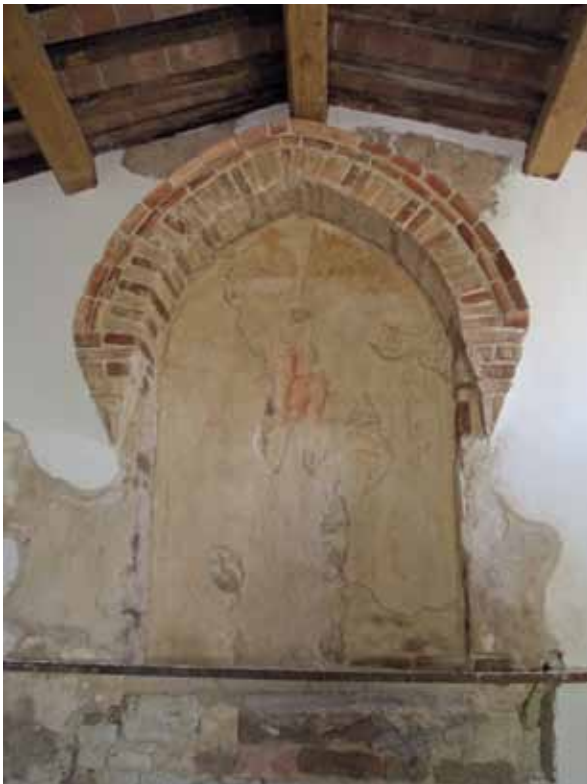
Fig. 7 - L'interno durante il restauro. Particolare della sinopia
