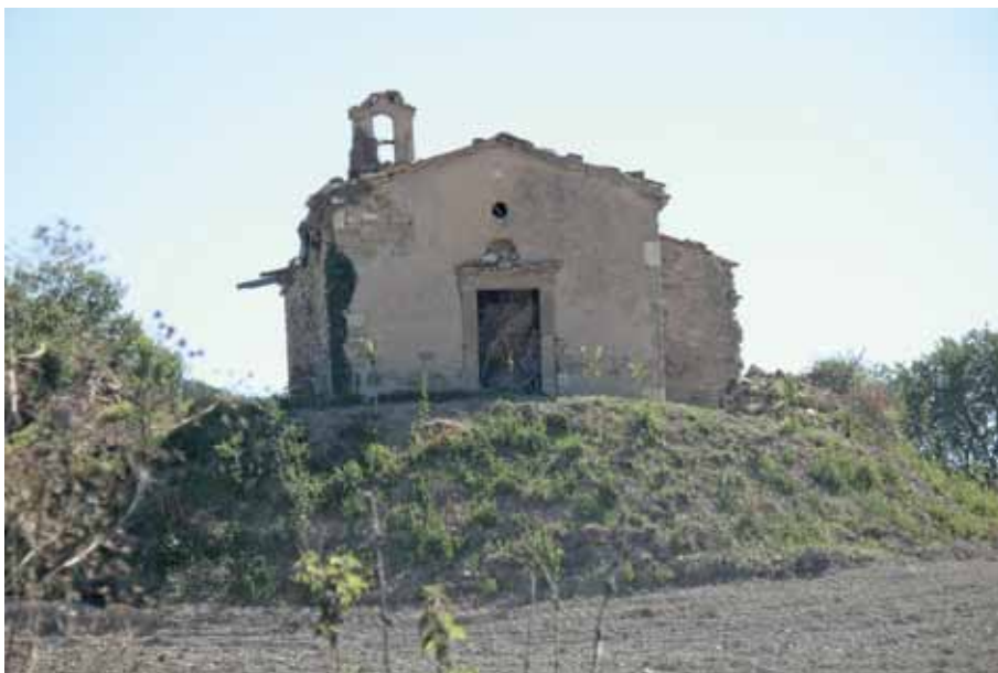
Fig. 3 - Il fronte Ovest prima dell'intervento di restauro
