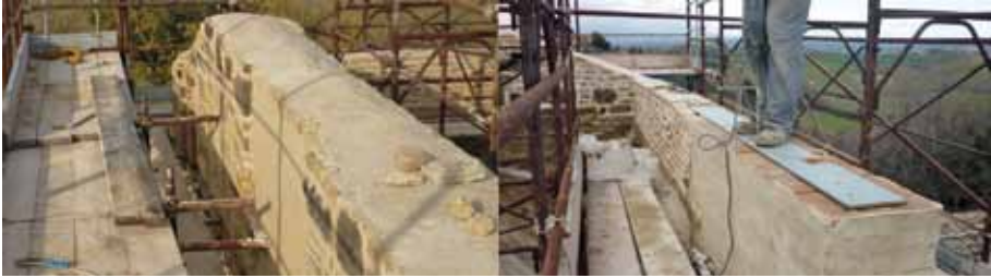
Fig. 13 - Muratura sommitale - cordolatura metallica
