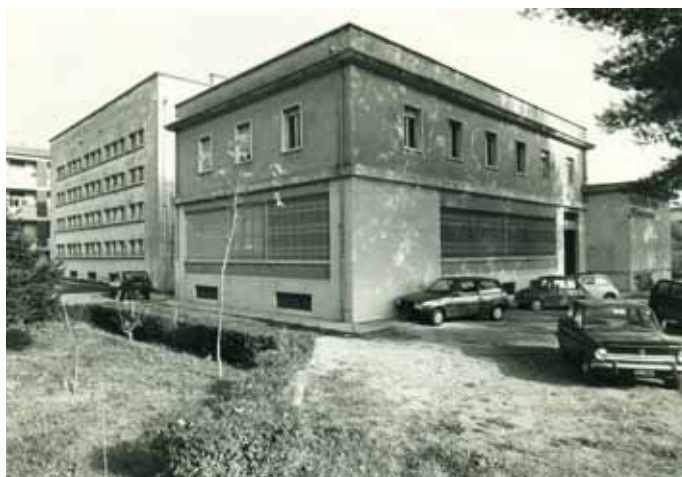
Fig. 3 - Veduta dei corpi edilizi separati
