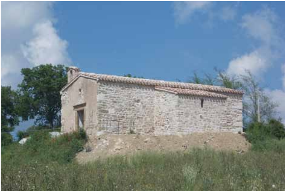
Fig. 6 - Il lato Sud durante il restauro.
