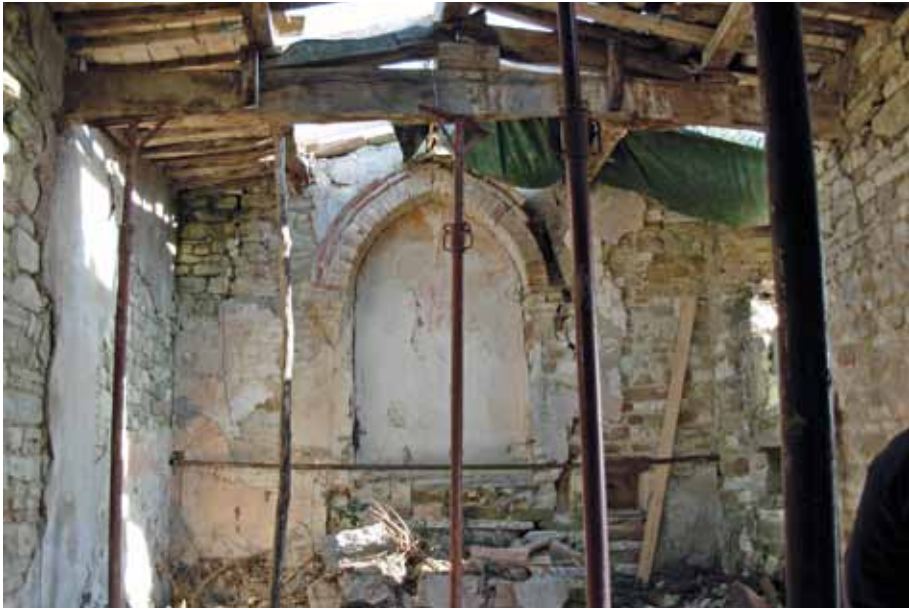
Fig. 4 - L'interno prima dell'intervento di restauro
