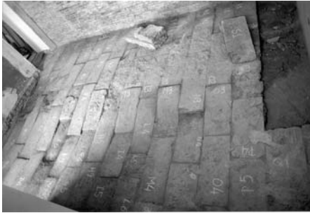
Fig. 19 - Ex Scuola Marinara - pavimentazione dell'antico molo prima dell'intervento di restauro
