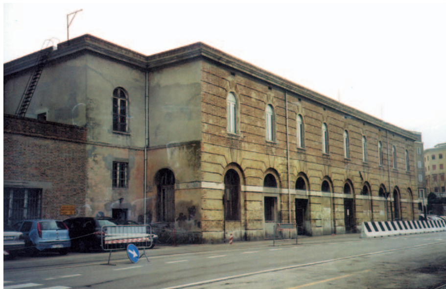
Fig. 12 - L'edificio "ex infermeria" prima del restauro
