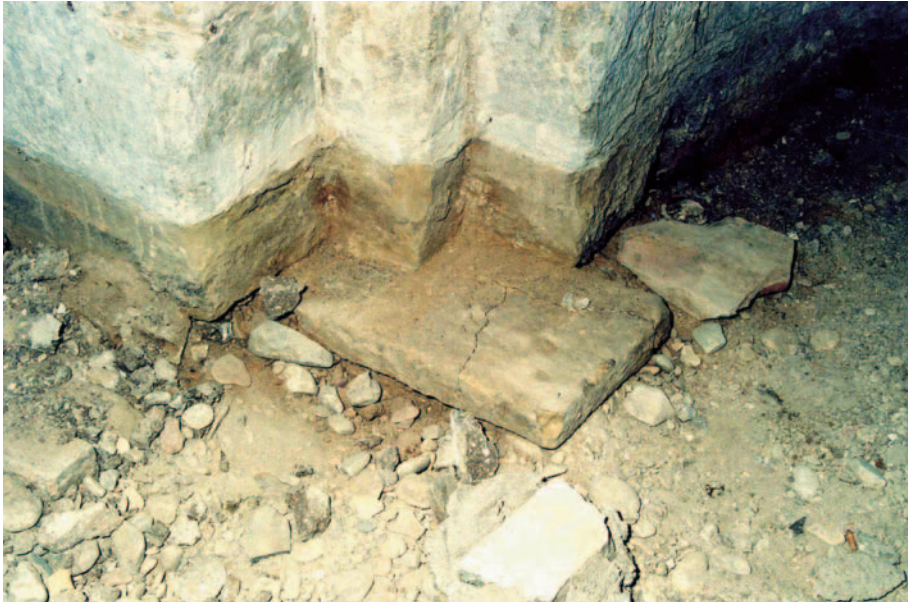
Fig. 17 - Laterizio pavimentazione originaria
