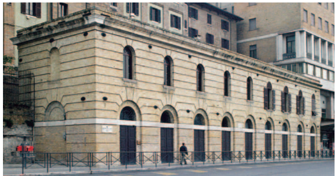
Fig. 18 - Ex Scuola Marinara - esterno dopo dell'intervento di restauro
