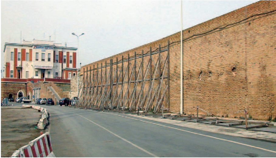
Fig. 2 - Le mura del "braccio nord" prima del restauro
