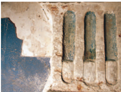
Foto 4 - Le "macchie" gialle corrispondono alla residuale presenza delle doratura a foglia del peduccio
