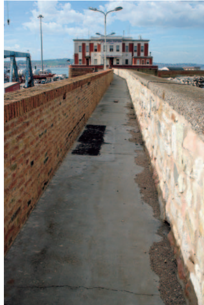
Fig. 5 - Il camminamento superiore dopo del restauro
