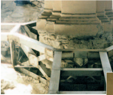
Fig. 14 - Chiesa superiore particolare traliccio metallico
