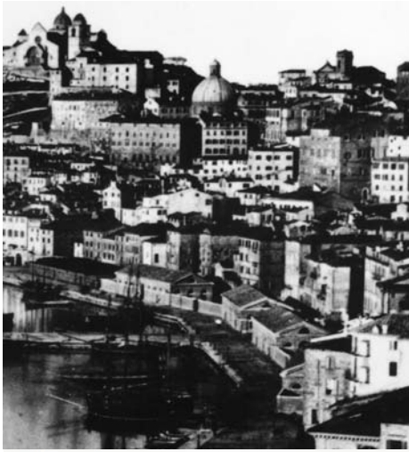
Fig. 6 - Magazzini generali all'epoca della loro costruzione - 1870 circa
