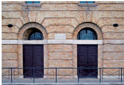
Fig. 22 - Ex Scuola Marinara - esterno dopo dell'intervento di restauro
