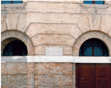
Fig. 21 - Ex Scuola Marinara - esterno prima dell'intervento di restauro
