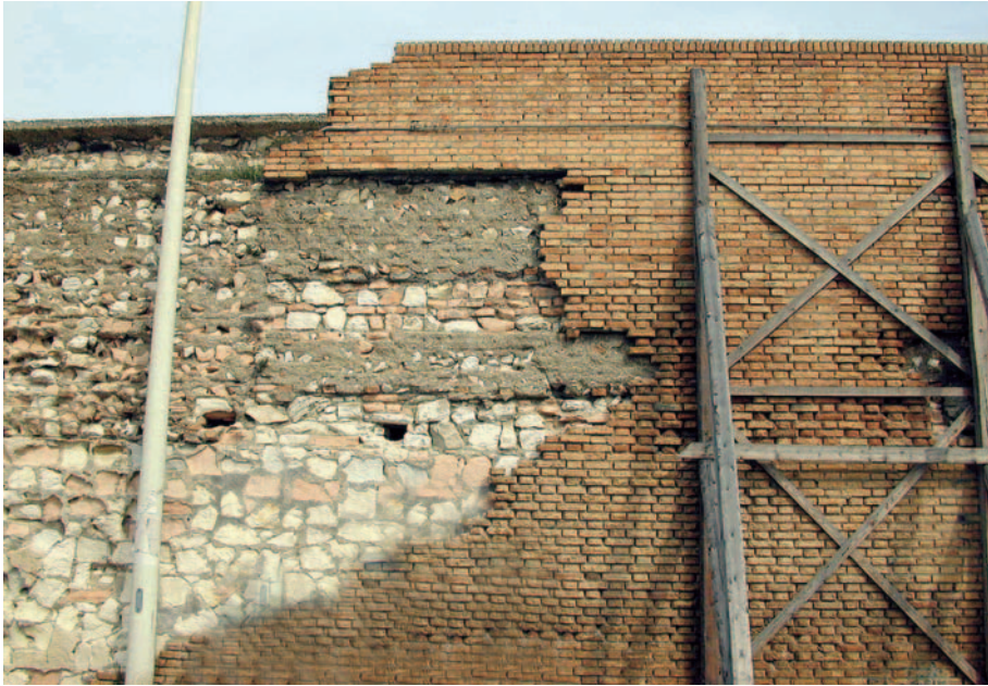
Fig. 1 - Le mura del "braccio nord" prima del restauro
