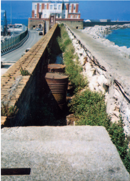
Fig. 4 - Il camminamento superiore prima del restauro
