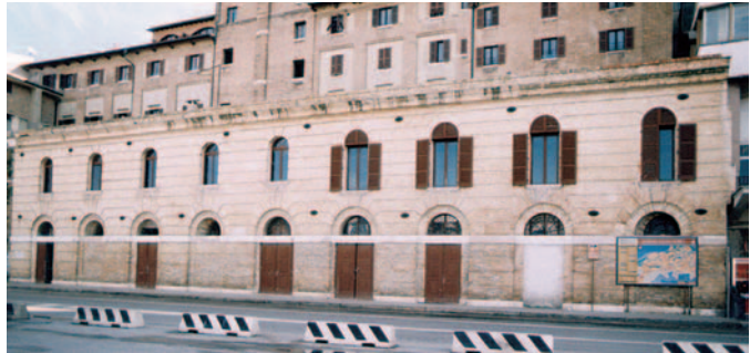
Fig. 17 - Ex Scuola Marinara, esterno prima dell'intervento di restauro
