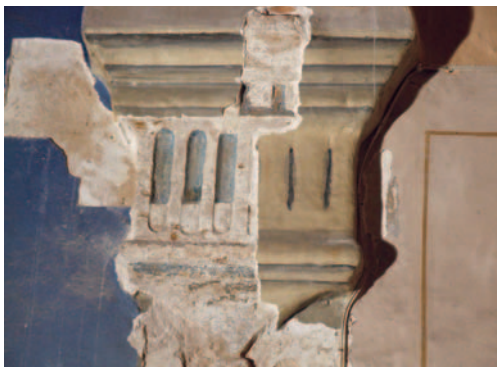
Foto 2 - La forma e le dimensioni reali del peduccio
