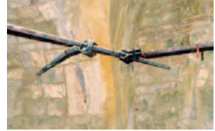
Fig. 4 - 1902 Tirantature metalliche
