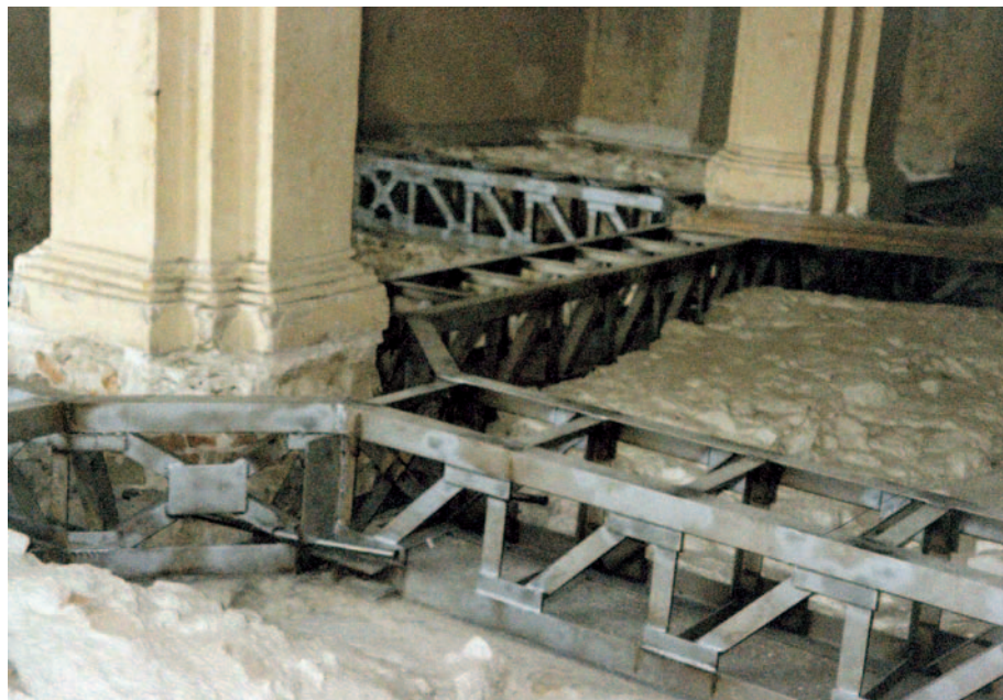
Fig. 15 - Chiesa superiore particolare traliccio metallico
