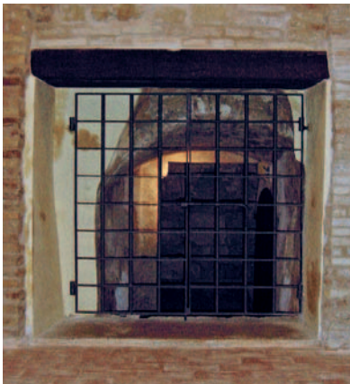
Fig. 24 - Cripta accesso galleria dei morti
