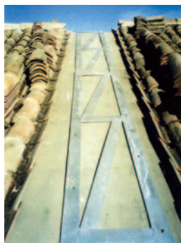
Fig. 4 - La copertura - Opere di consolidamento e miglioramento sismico.
