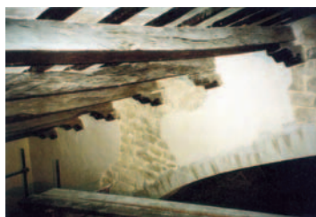
Fig. 5 - La navata - Opere di consolidamento murario.
