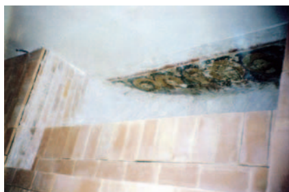
Fig. 8 - Parete di fondo della tribuna absidale - Asola ricavata tra i frenelli in muratura per rendere visibile l'affresco rinvenuto.
