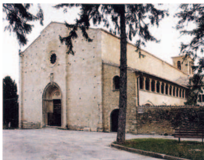
Fig. 3 - L'esterno della Chiesa di S. Esuperanzio a seguito del restauro.
