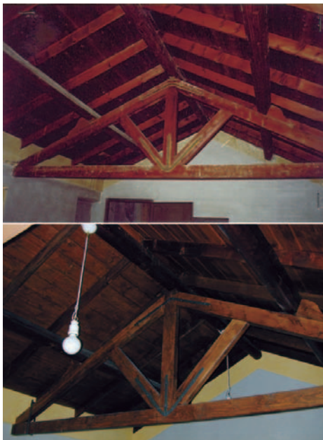
Fig. 5 - Prima e dopo i lavori di restauro
