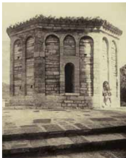
Foto 7 - Il tempio Romanico dopo i lavori del restauro condotto da Luigi Serra. Si nota appena la cerchiatura metallica del tiburio, verniciato color della pietra come disposto dal Soprintendente
