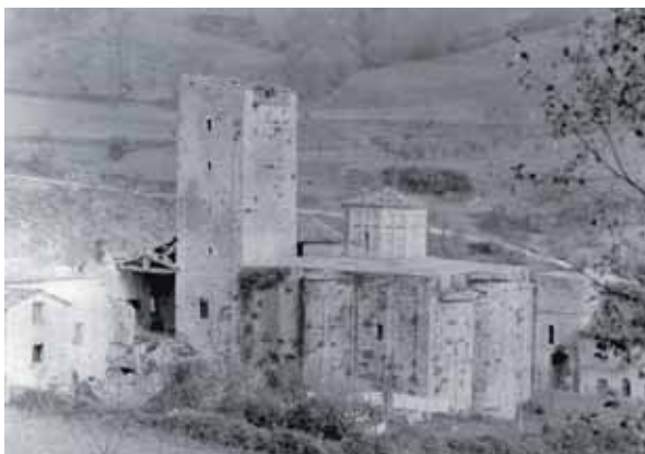
Foto 11 - Il tempio Romanico negli anni '60. Si notano la torre "a testa di ponte" restaurata in sommità, i resti del monastero addossato alla chiesa e la presenza delle buche pontai e sulle murature
