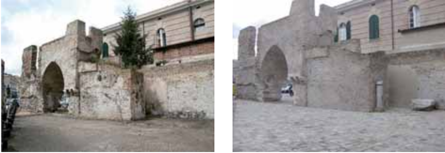
Foto 4 - Portella Panunzi - Fronte città - prima e dopo il restauro
