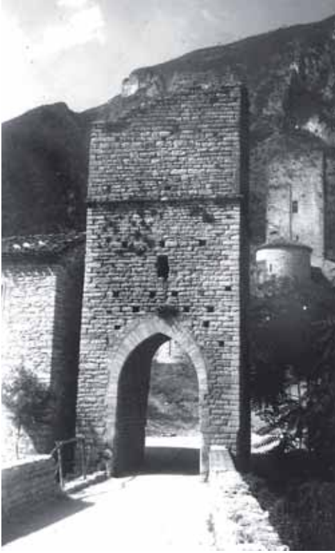
Foto 10 - La torre "a testa di ponte" nel 1947. La risagomatura dell'arco è già stata eseguita
