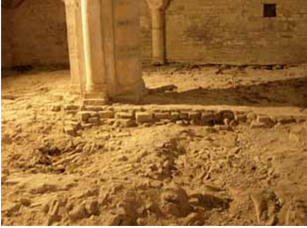
Foto 8 - Chiesa di Sant'Urbano ad Apiro durante i lavori post-sima (luglio 2009). Si notino i lacerti lapidei del sottofondo della pavimentazione ed i riempimenti delle volte
