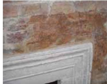
Fig. 1 - Particolare della finitura superficiale ad intonaco tinteggiato dopo il completamento dell'intervento di restauro
