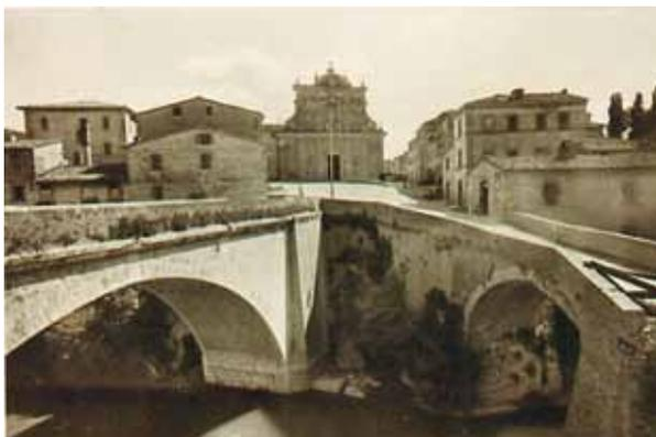
Fig. 3 - Foto precedente al 1951. Si notano i due ponti antico e nuovo ed il fronte della chiesa ancora privo del sagrato, segno che l'abbassamento stradale non era ancora stato realizzato
