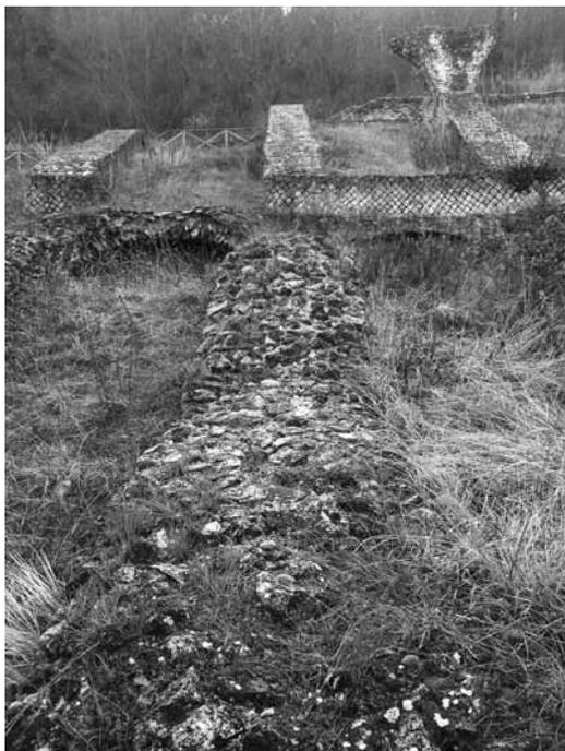
Fig. 4 - Il radiale 144 prima degli interventi di consolidamento della struttura e di rifacimento della copertina di protezione. Le malte della copertina di protezione sono quasi del tutto incoerenti, consentendo la presenza di vegetazione e l'infiltrazione delle acque meteoriche, che a causa del gelo provocano delle accentuate cadute di materiale anche nella muratura antica (2008)
