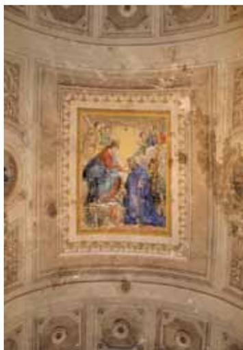
Fig. 1 - Degradato della volta dell'abside dopo la crisi sismica 1997
