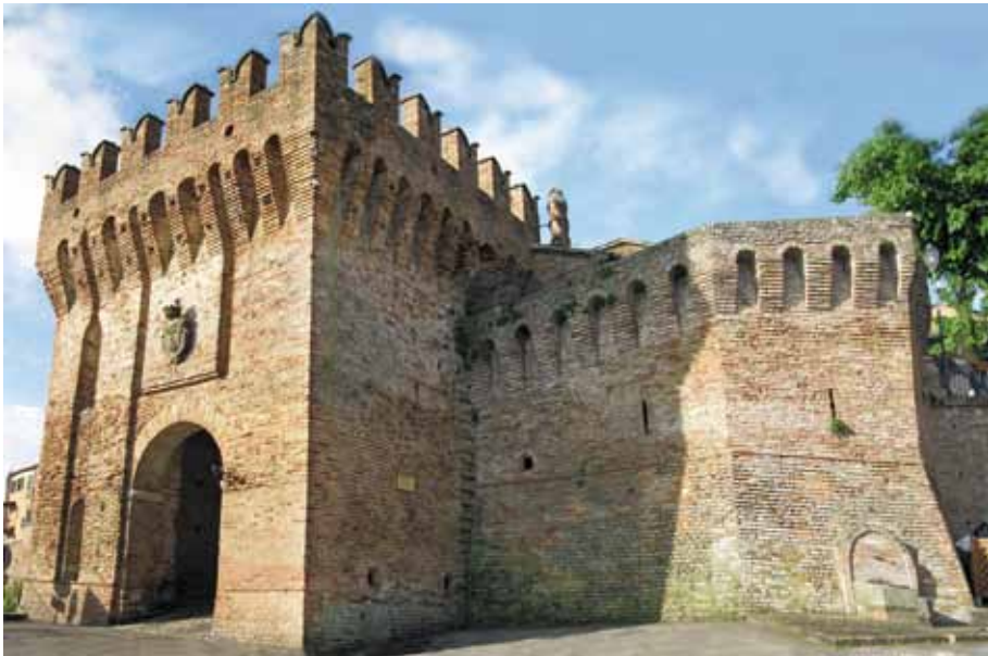
Fig. 1 - Porta San Giovanni - Lato esterno prima dei lavori
