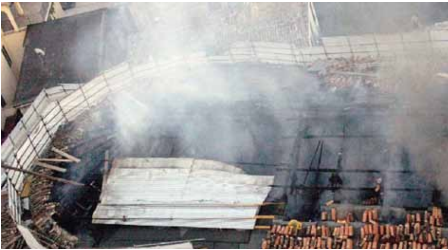
Fig. 1 - Teatro dopo l'incendio
