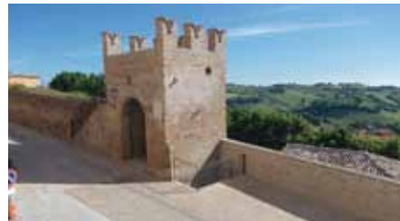
Fig. 2 - Il vicolo dopo il restauro
