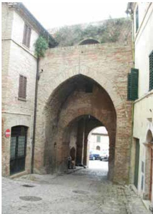
Fig. 2 - Porta San Giovanni - Lato interno prima dei lavori
