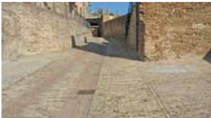
Fig. 1 - Vicolo dello Scorticatore prima dei lavori
