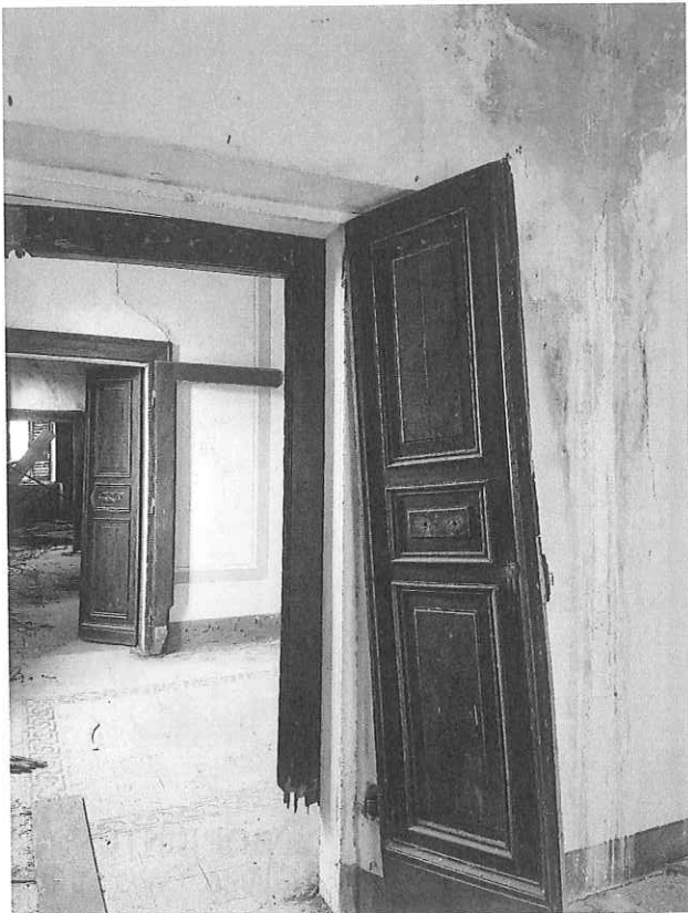
Porte e corridoio
