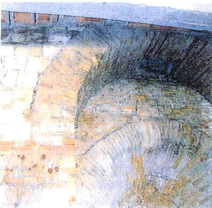
A livello della Flaminia si aprono due profonde bocche da fuoco in mattoni con arcate rastremate, al centro delle quali (come segno devozionale) è stata realizzata una Croce con piastrelle incassate al di sotto del filo della muratura. Solamente sulla volta della bocca di destra è visibile il foro di un camino.
