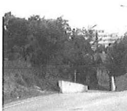
FERMO PILONE DEL VIADOTTO MADONNA DEL FERRO
