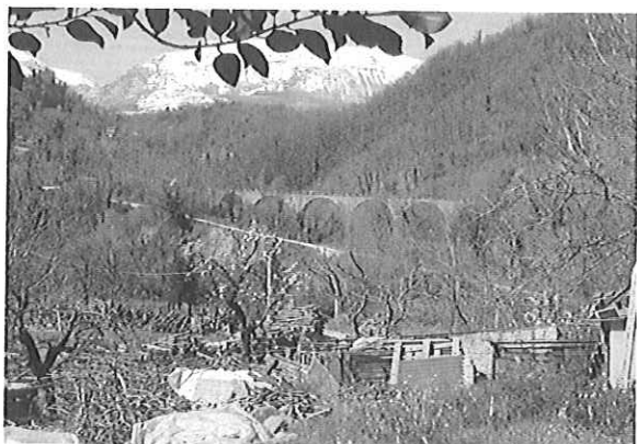
VIADOTTO SUL FOSSO CALLUGO
