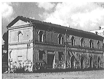
Stazione di P.S. Giorgio prima dei lavori
