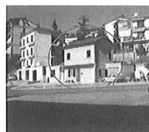
FERMO CASELLO N. 6 VIA XXV APRILE (inglobato dalle moderne costruzioni)
