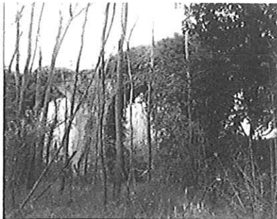
TESTA DI PONTE SUL FOSSO CASTELLANO
