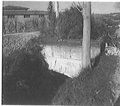
PONTE FOSSO FERRARINI
