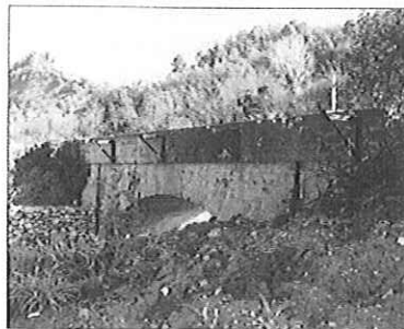
PONTE IN CONTRADA MOLINO
