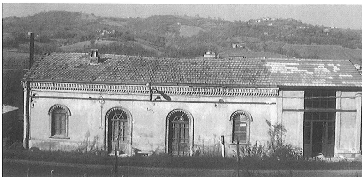
La fronte ingresso passeggeri prima dei restauri
