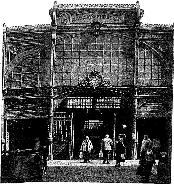
Perimetralmente al corpo centrale è stato realizzato, su lati nord, est e ovest, un volume a doppia altezza con struttura portante in muratura e ghisa, che si raccorda tramite travature reticolari agli arconi principali.
